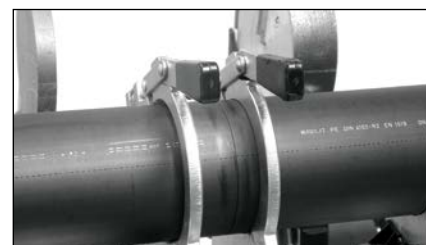
Správně připravené potrubí ke svařování
