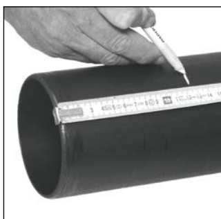
Označení požadované zásuvné délky
