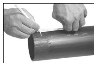
Označení požadované zásuvné délky
