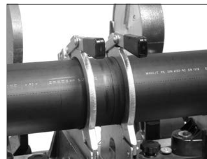
Správně připravené potrubí ke svařování
