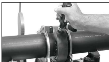
Srovnání konců potrubí integr. hoblíkem
