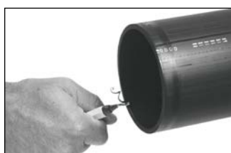
Odstranění otřepů a nerovností řezu
