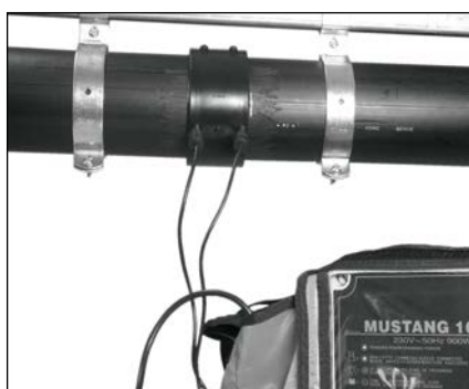
Svařování pomocí elektrodoporového nátrubku
