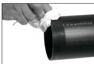
Ošetření konců potrubí PE čistícím přípravkem
